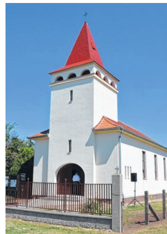
A magyarkeresztúri evangélikusok idén nyáron fejezték be templomuk felújítását.
